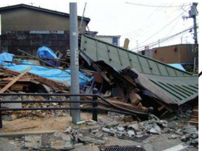
倒壊した家屋
