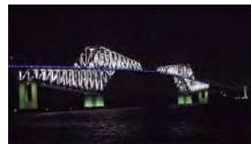
<東京ゲートブリッジ>
