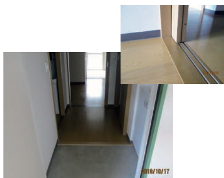
<床の段差解消の例>
