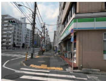
<無電柱化(施工前)>
