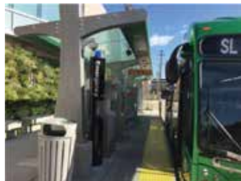
<上屋を設けた停留施設の例> (アメリカ合衆国ミシガン州 グランドラピッズ)
