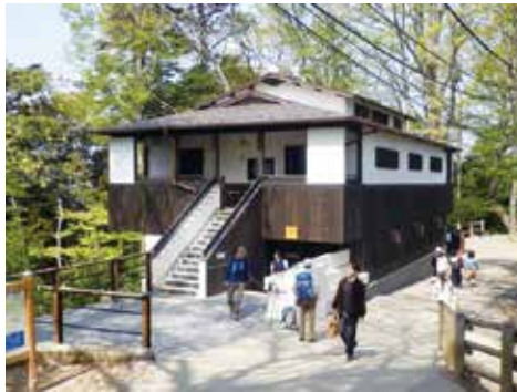
<大見晴園地のトイレ外観>
