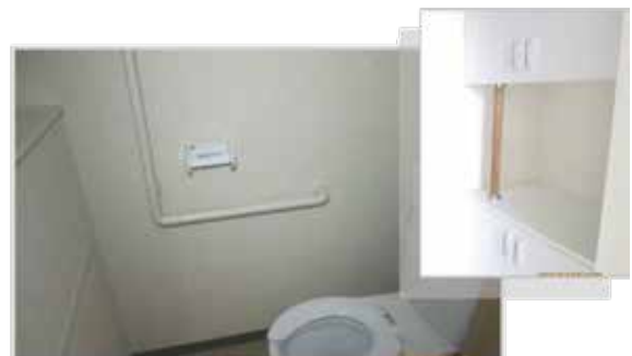
立上り動作が必要な場所及び 段差が残る場所には手摺を設置
