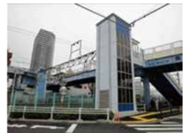
<横断歩道橋のエレベーター整備例>
