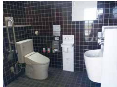
<手すり等を装備したトイレの例>
