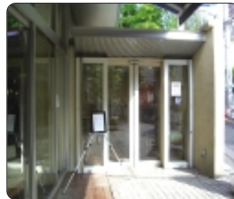
自動式引き戸の出入口
