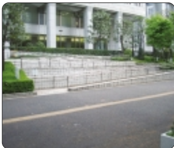
スロープは2回の切返しがあり、総延長は約80メートル
