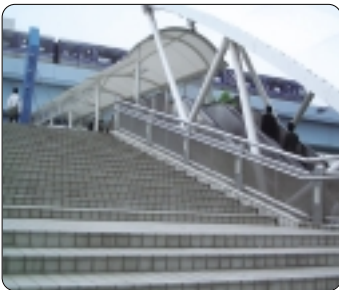
エスカレーター部分
