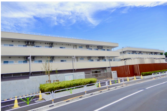
建物全景写真
