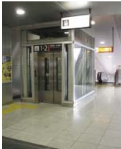
JR青梅線 羽村駅のエレベーター (平成19年度整備)
