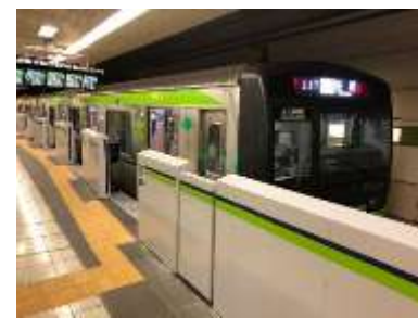
ホームドアの設置状況 〈都市整備局・交通局〉
