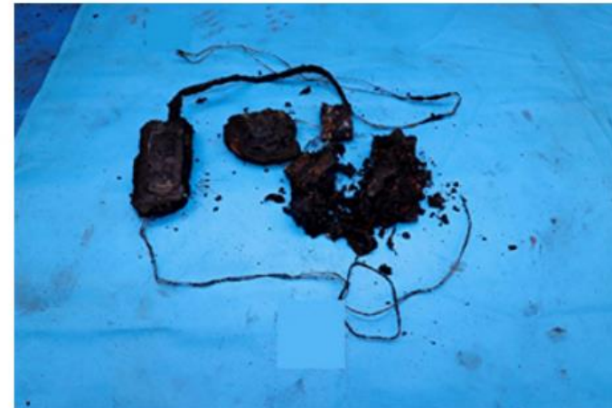
バッテリーの焼損状況
