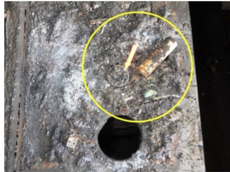
携帯型扇風機の焼損状況
