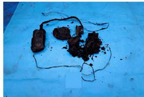
バッテリーの焼損状況
