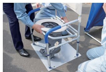
マンホールトイレ
