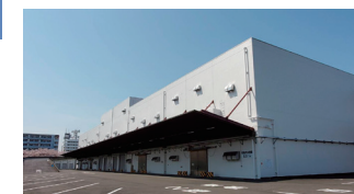
多摩広域防災倉庫
