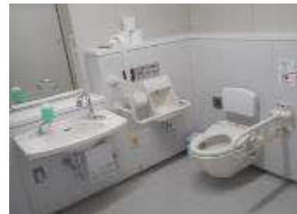
車椅子利用者対応トイレ等の設置 〈都市整備局・交通局〉
