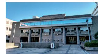
立川地域防災センター
