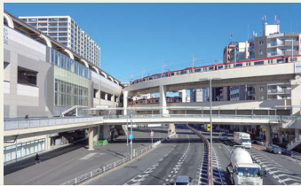
連続立体交差事業完了箇所 （京急空港線）
