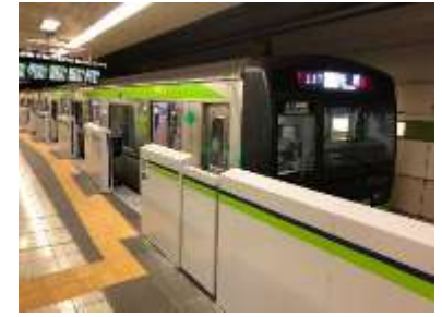
ホームドアの設置状況 〈都市整備局・交通局〉
