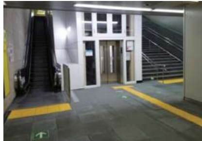
視覚障害者誘導用ブロックの設置状況 〈都市整備局・交通局〉
