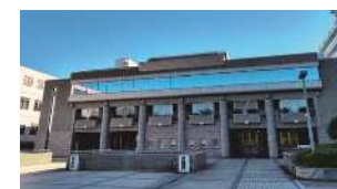
立川地域防災センター
