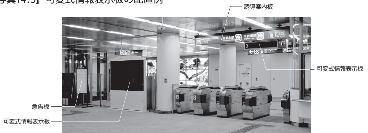
【写真14.5】 可変式情報表示板の配置例
