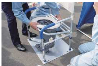
マンホールトイレ
