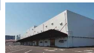
多摩広域防災倉庫
