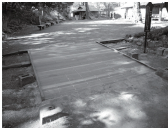
写真4 取り外しができる段差解消スロープ
