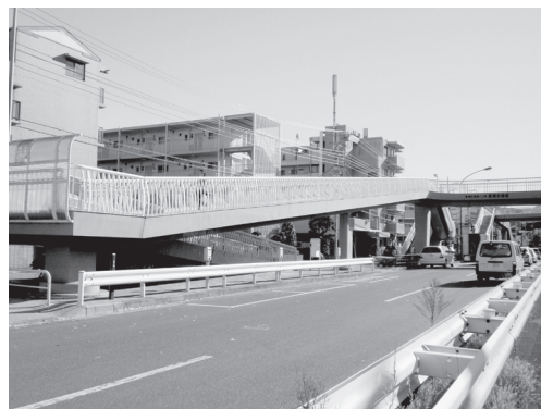
【写真10.1】 スロープの設置例
