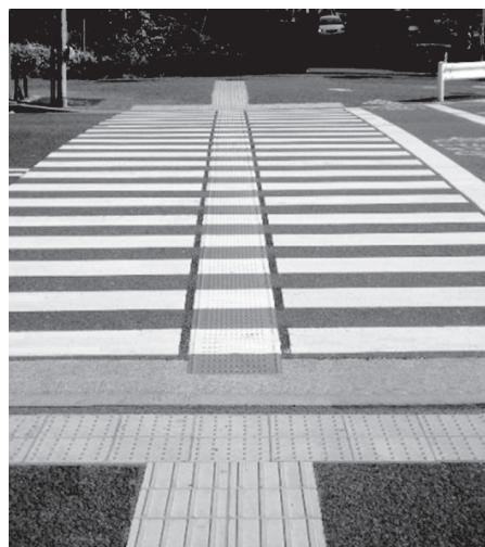
【写真8.1】エスコートゾーンの設置例
