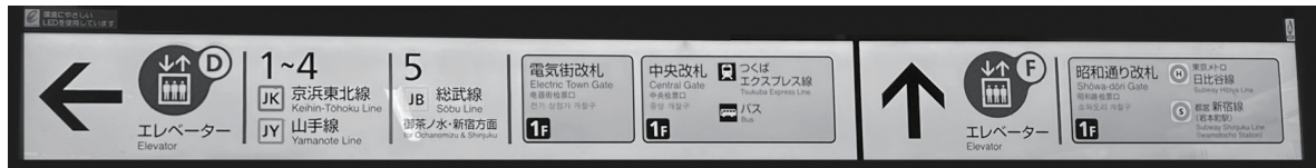
【写真14.3】天井吊下げ型の誘導サインの例
