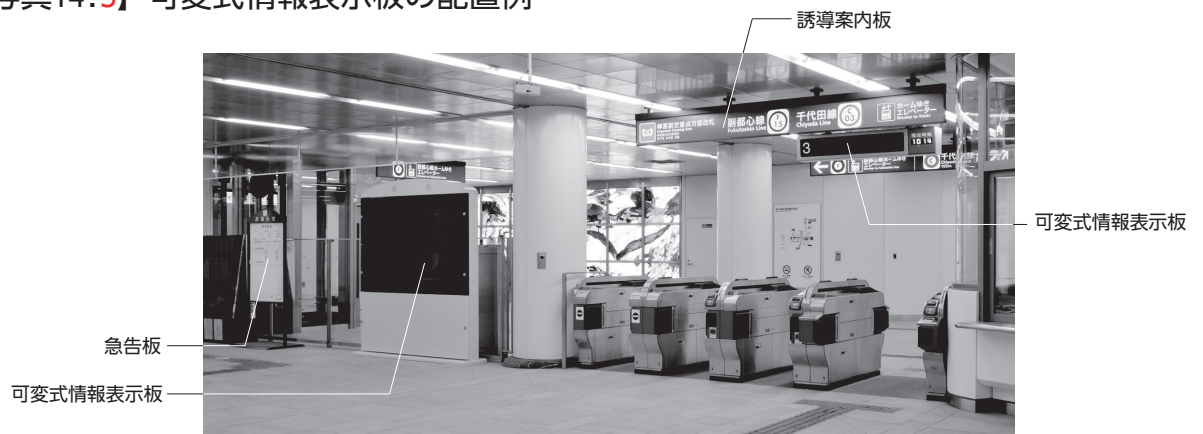
【写真14.5】 可変式情報表示板の配置例
